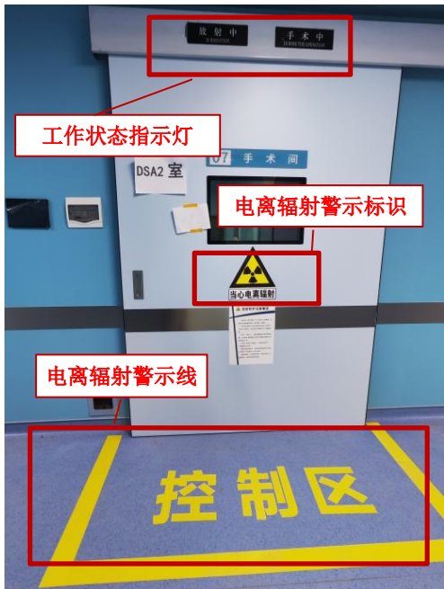
DSA2患者通道铅防护门、电离辐射警示标志、
